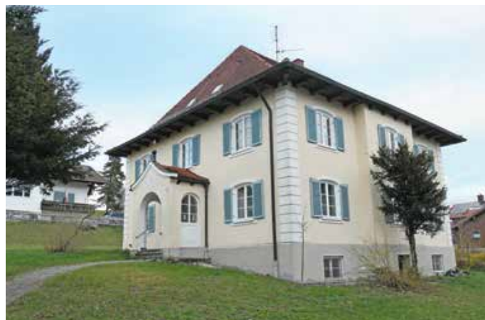
Das leerstehende Pfarrhaus in der Schlosstraße – Foto: Norbert Plattner
