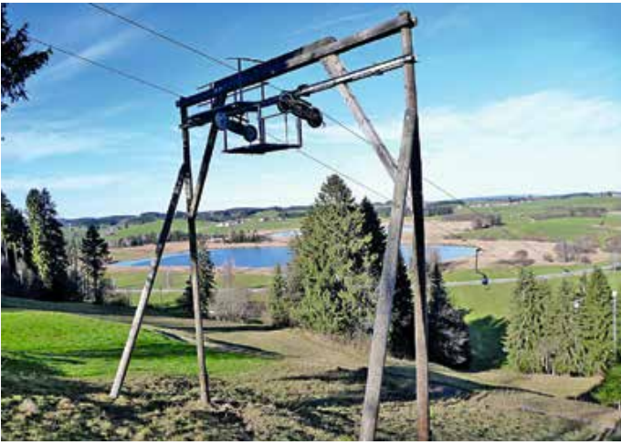
Die Stütze in Holzbauweise
